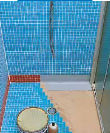
Vízszigetelés és fektetés előregyártott zuhanyzóblokkba
